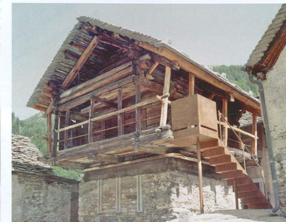
Torba Cittadella: geprägt von einer modernen Stahlterrasse. Torba Cittadella: caratterizzata da una moderna scala in acciaio.
